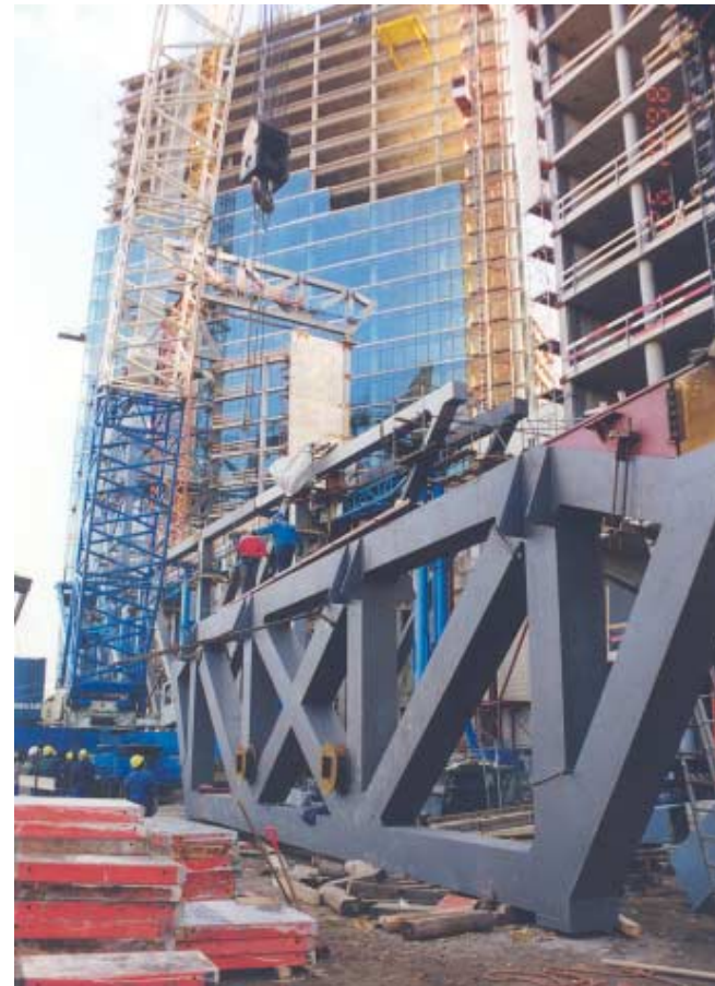
Statik, Konstruktion, Prüfung und Bauüberwachung von schwerem Stahlbau mit hochfesten geschweißten Feinkornbaustählen - SONY Center Berlin, Haus F (Esplanade)
